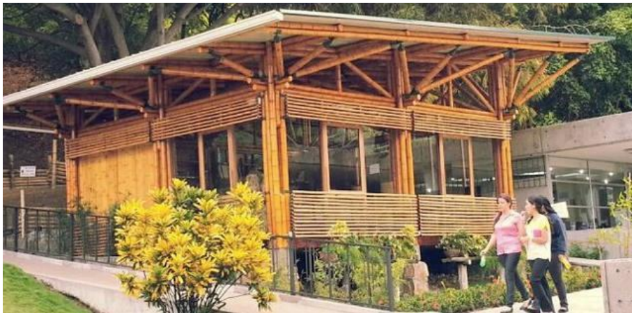
Figura 2. Vivienda en Ecuador a base de caña guadua Fuente: Ecuavisa
