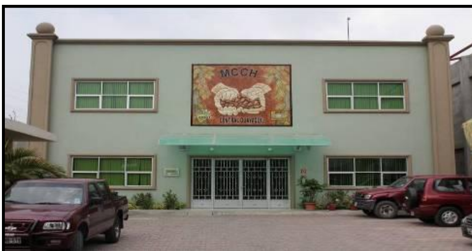
“Vista frontal de las instalaciones de MCCH”
