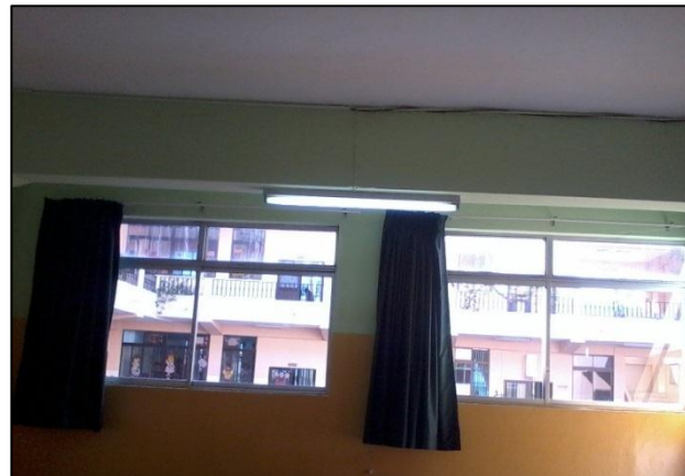
Imagen 22: Instalaciones de la Unidad de Producción
