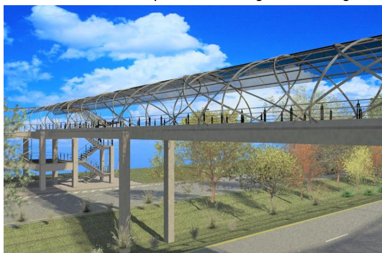
Ilustración 26. Puente peatonal con vigas de hormigón armado
