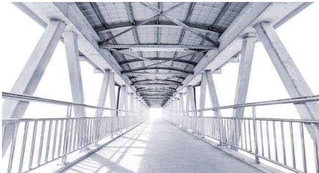
Ilustración 27. Paso peatonal con vigas de acero
