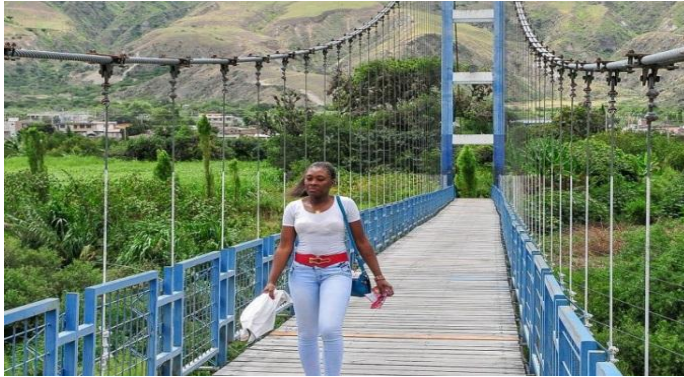
Ilustración 32. Puente colgante en el río chota, Ecuador
