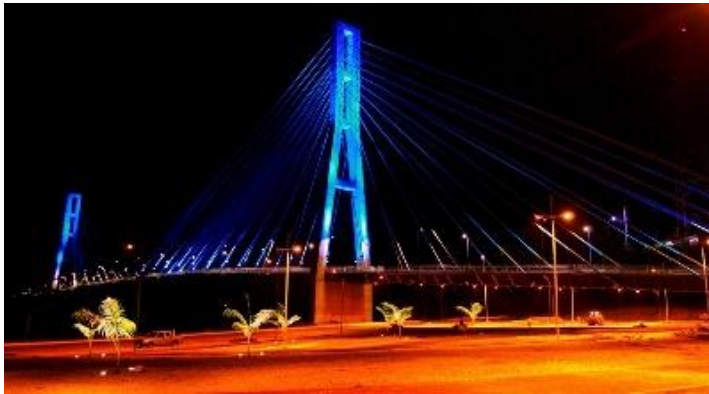
Ilustración 30. Puente atirantado en Puerto Aguarico, Sucumbíos- Ecuador
