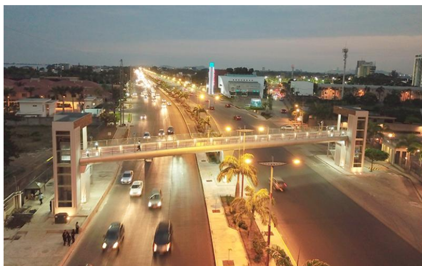
Ilustración 34. Estructura prefabricada del paso peatonal de Plaza Navona y Alhambra, Vía a Samborondón
