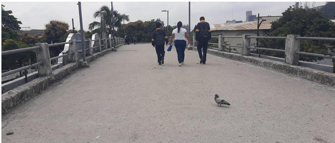
Ilustración 10. Usuarios expuestos al sol debido a la falta de zonas cubiertas
