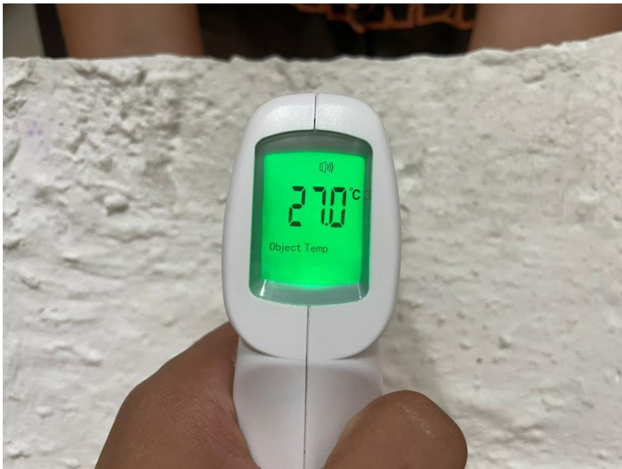
Ilustración 74: Temperatura de 27°C en la cara fría del panel de la dosificación 3.
