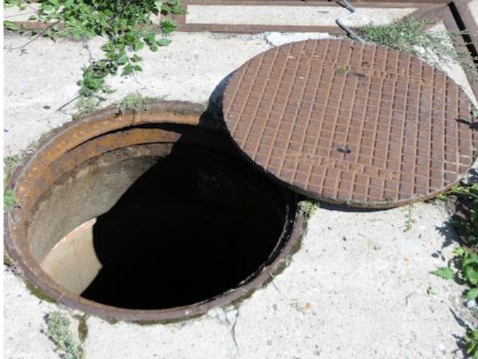
Figura 24: Pozos de Inspección
