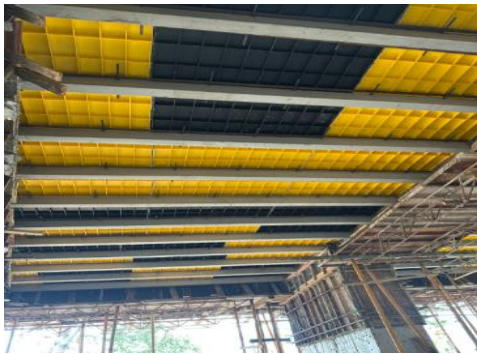
Figura 4. Encontrado de una losa con sistema nervada.
