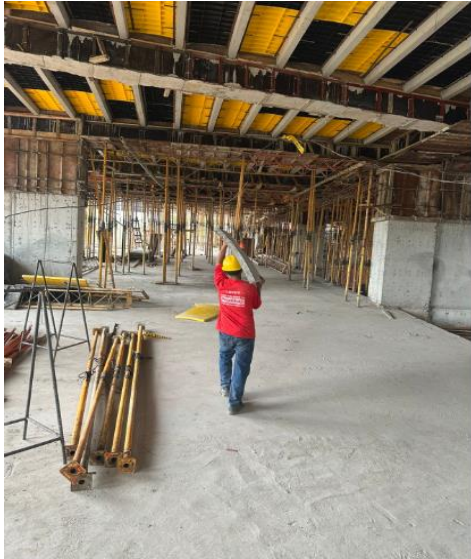
Figura 7. Movilización de encofrado metálico.
