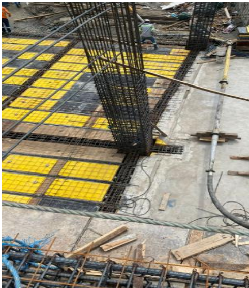
Figura 12. Losa con tableros plástico.
