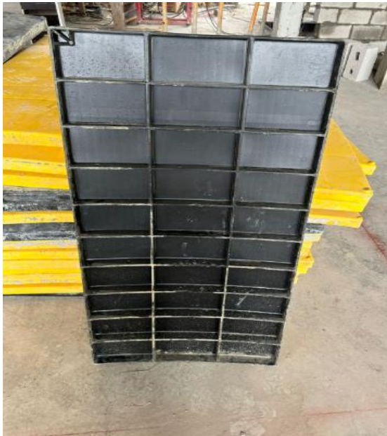
Figura 10. Encofrado de plástico después de desencofrar.
