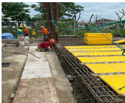
Figura 1. Encofrado en sitio listo para la colocación de malla.
