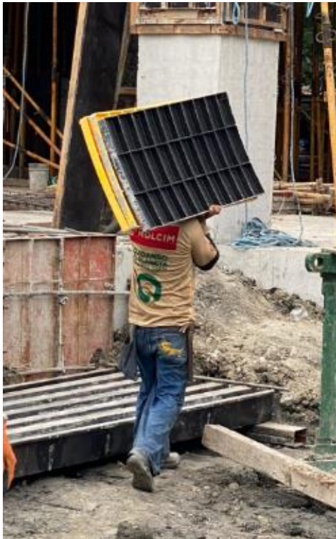
Figura 6. Movilización de encofrado plástico.
