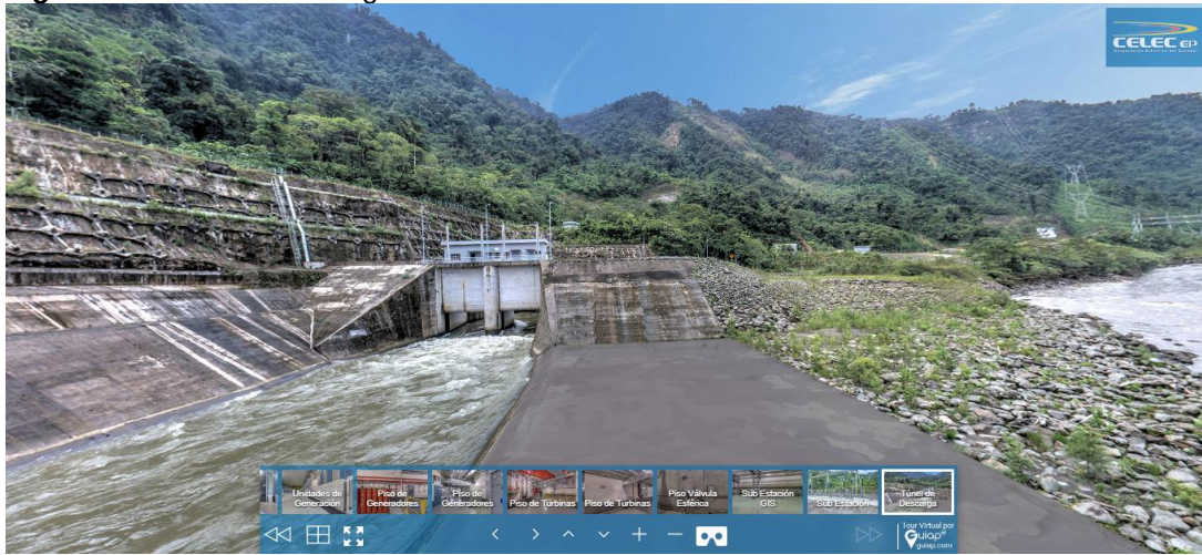
Figura 16 Túnel de Descarga
