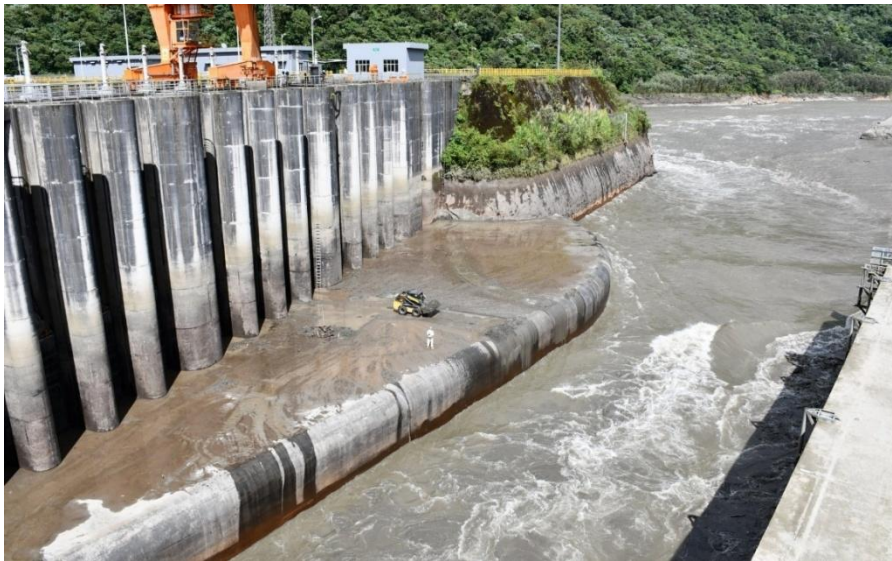
Figura 20. Limpieza de la sedimentación
