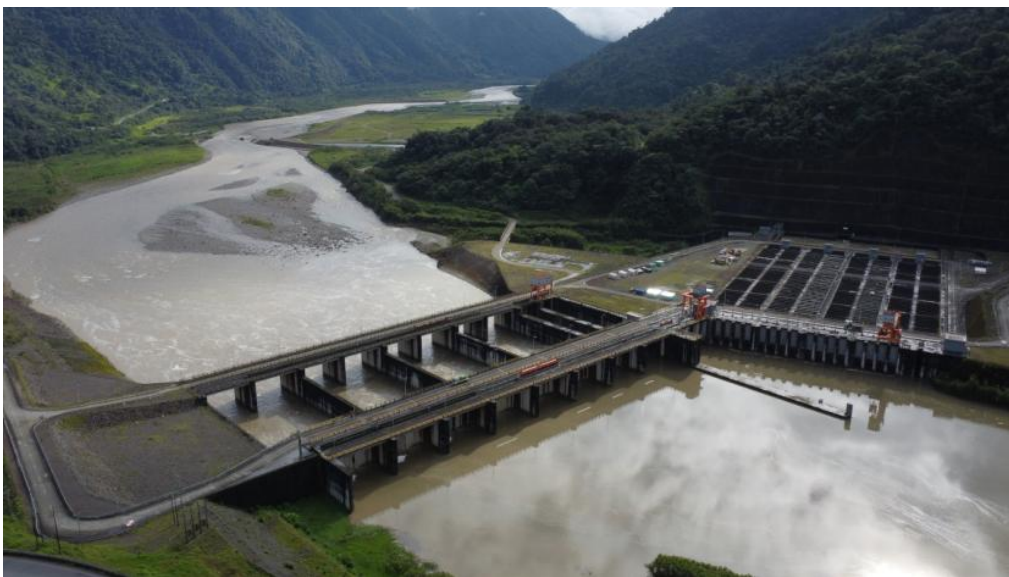
Figura 19. Infraestructura de captación
