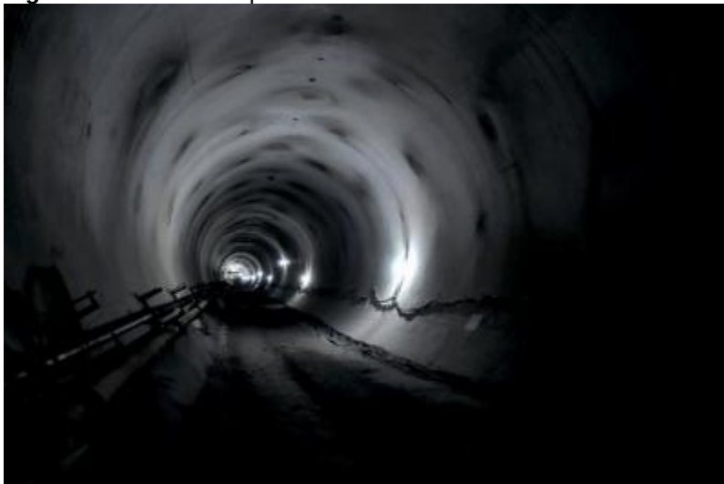
Figura 14. Tubería de presión
