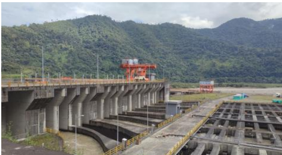
Figura 4 Canal de derivación
