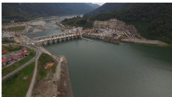
Figura 6 Obra de Captación
