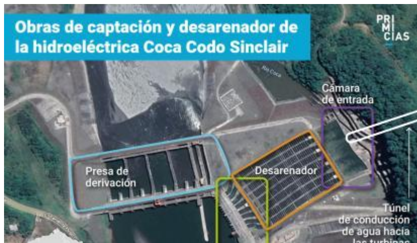
Figura 21. Obras de captación y desarenador de la Hidroeléctrica
