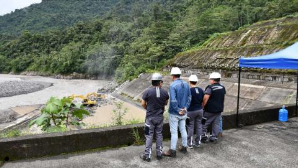
Figura 50. Evaluación del Mantenimiento
