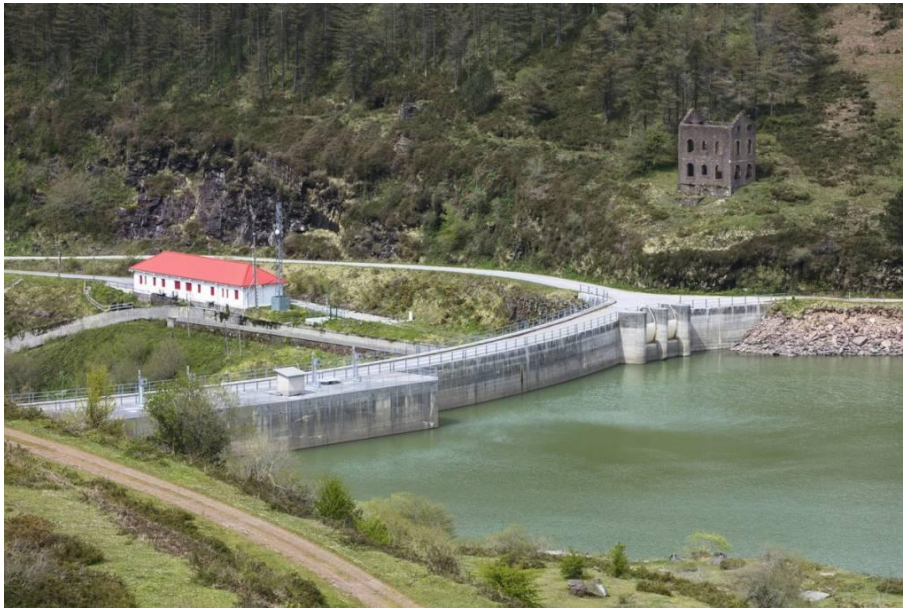
Figura 3 Central con bombeo
