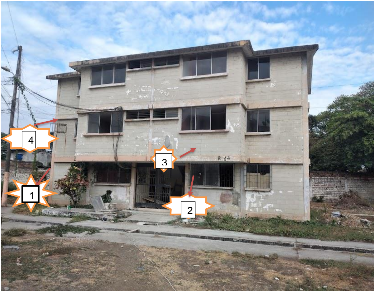
Figura 27: Lugares de los que se extrajo los Núcleos del bloque No 24.
