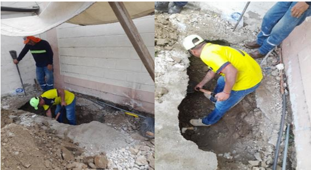
Figura 20: Calicata a mano exploración de cimentación
