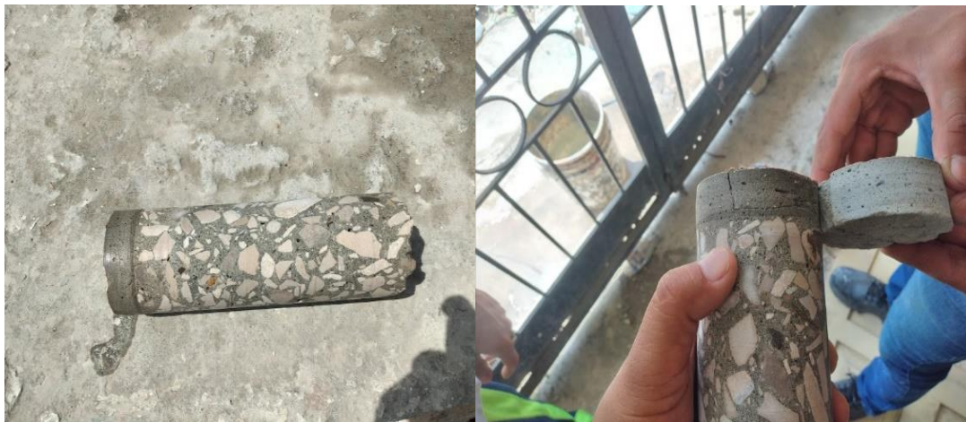
Figura 29: Imágenes de la extracción de muestras de columna planta baja
