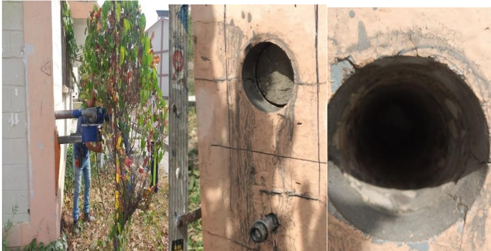
Figura 28: Imágenes de la extracción de muestras de columna planta baja
