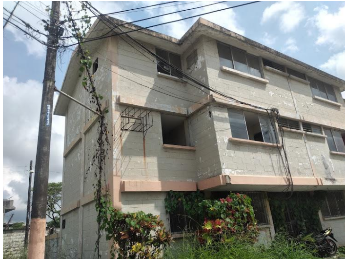
Imagen Lateral Izquierda Bloque 24 Fuente: Autor
