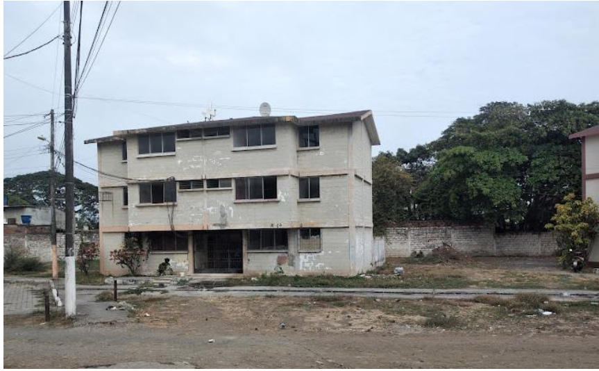
Imagen Frontal Bloque 24 Fuente: Autor
