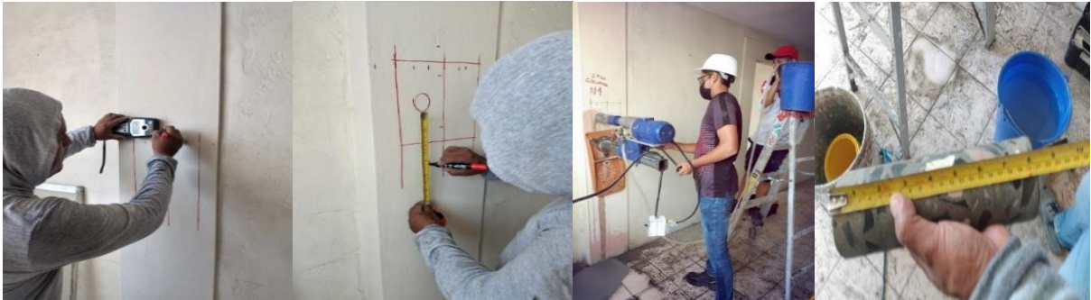
Figura 36: Imágenes de la extracción de muestras de columna planta primer piso alto
