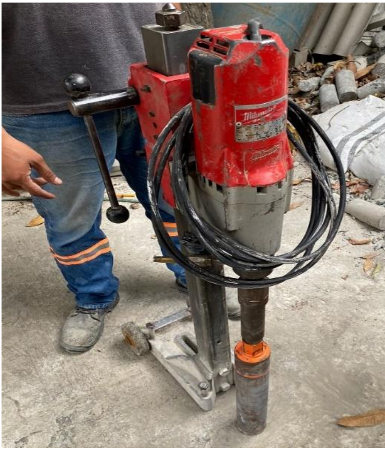
Ilustración 14: Perforación de un agujero en la estructura del pavimento
