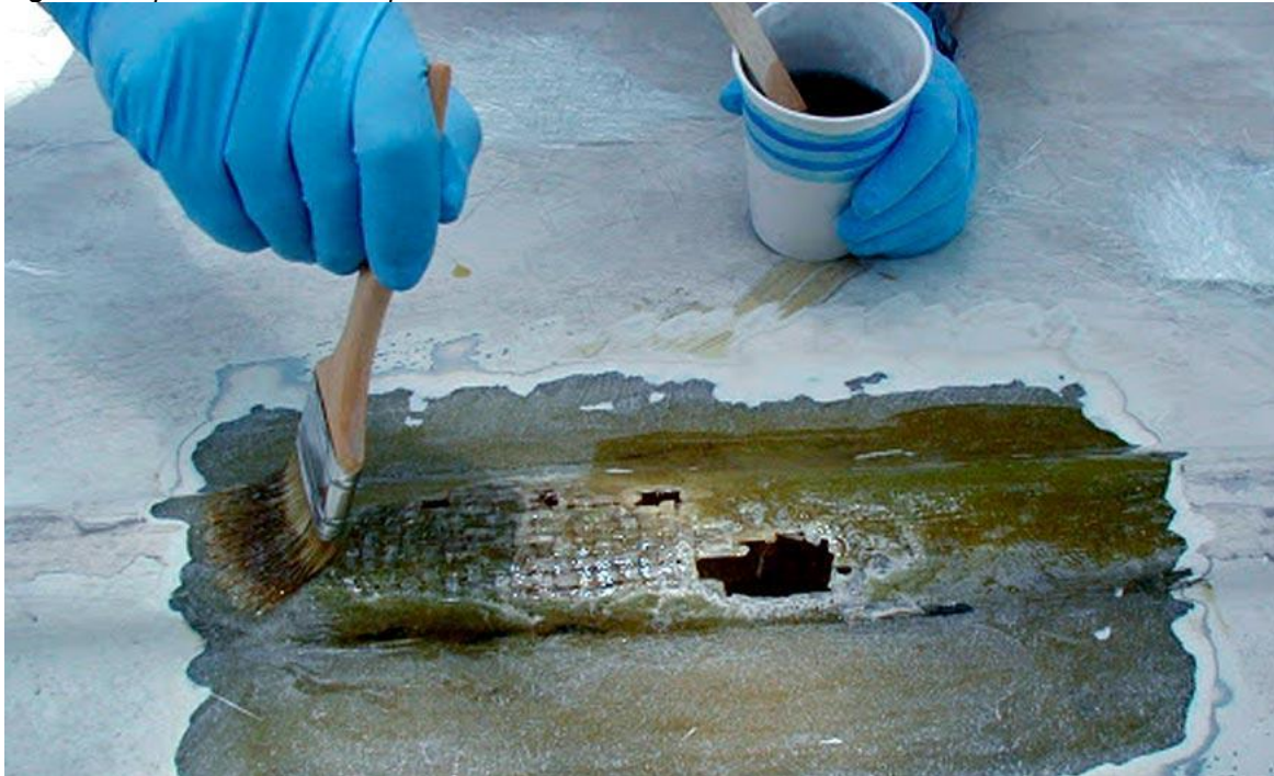
Figura 30. Aplicación de Resina poliéster
