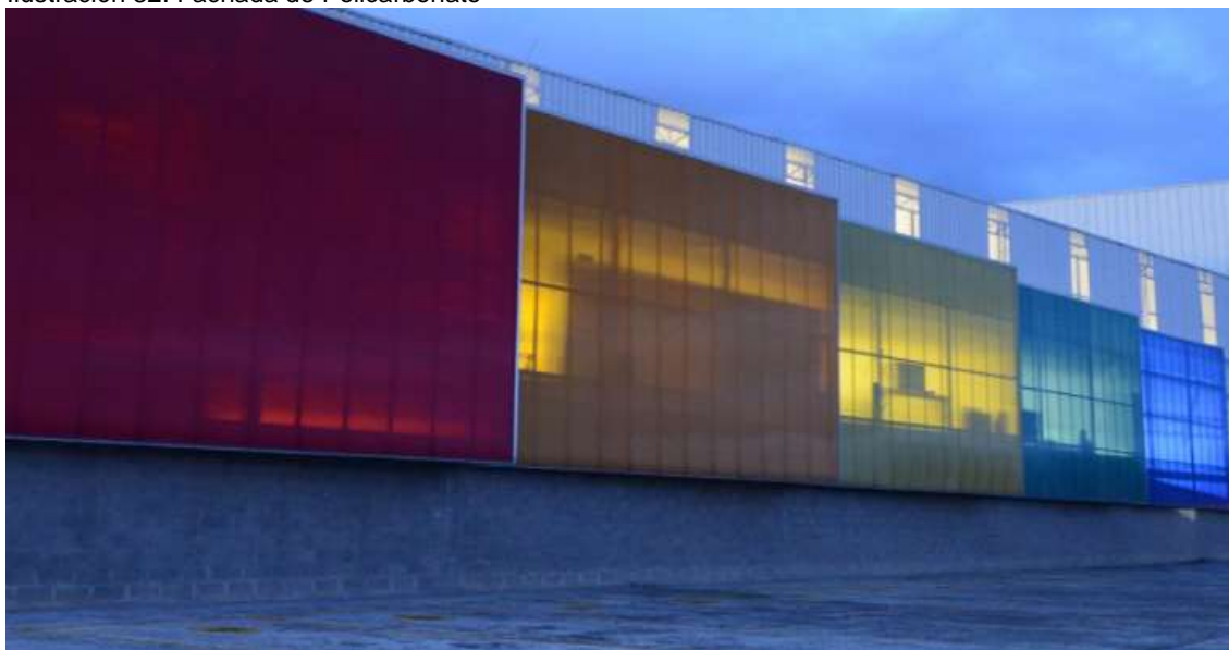
Ilustración 32: Fachada de Policarbonato
