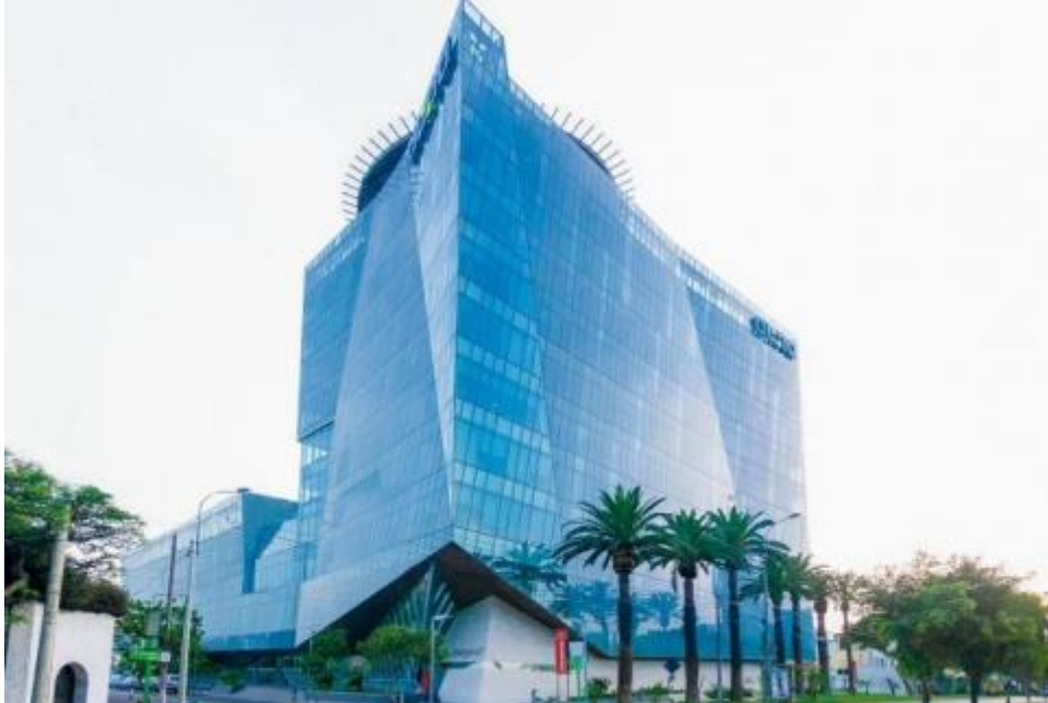
Ilustración 1: Edificación desproporcionada con el entorno
