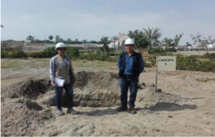
Figura 15. Excavación de calicata
