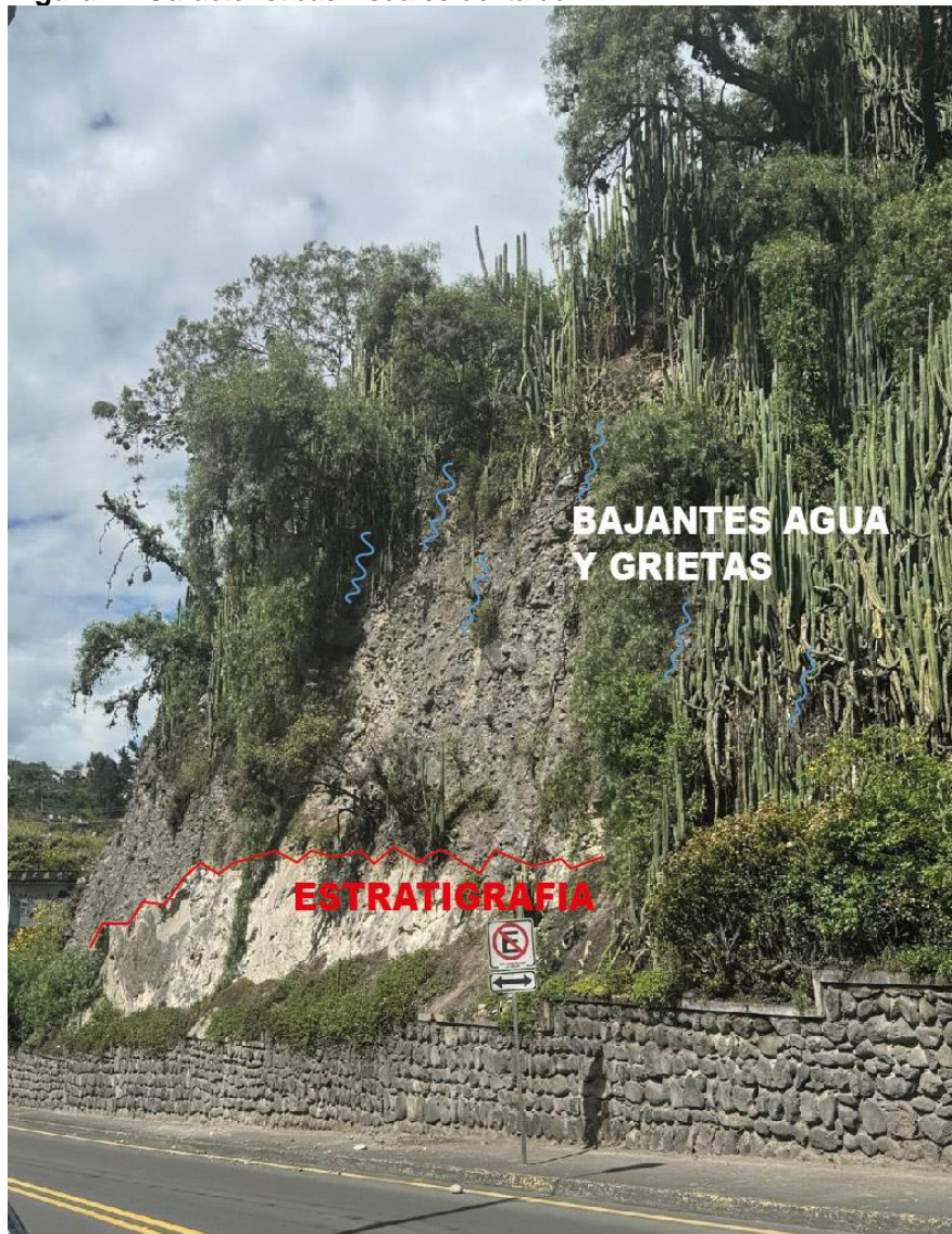
Figura 24 Características visuales del talud
