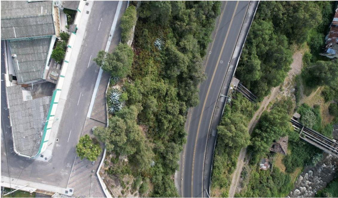
23 Anexo. Sistema antiguo de alcantarillado
