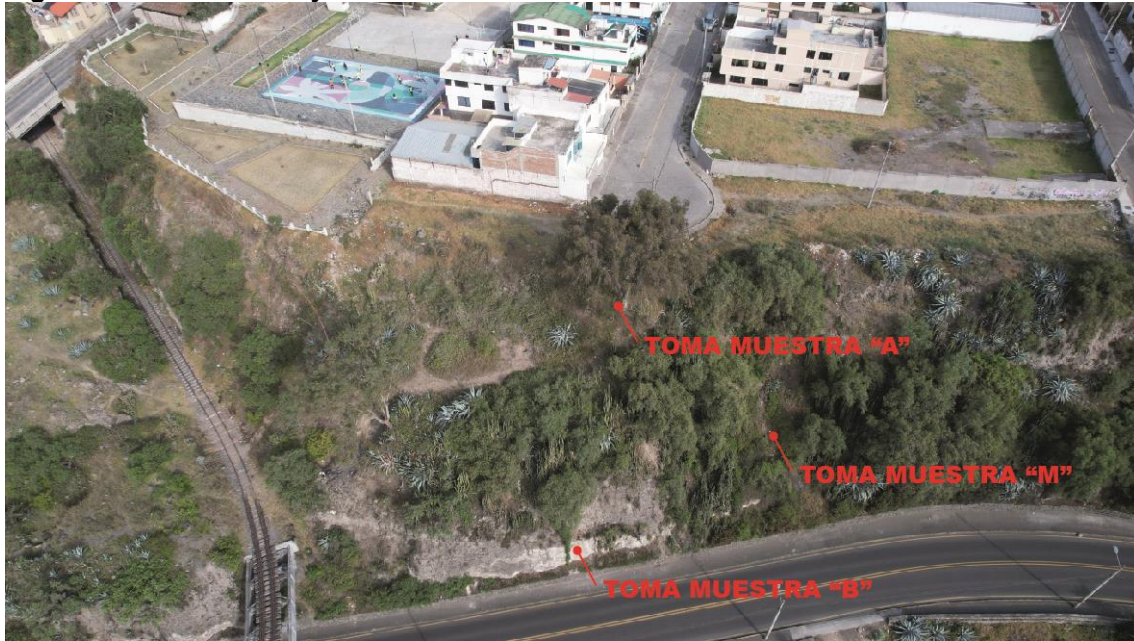
Figura 15 Identificación y toma de Muestras en el talud
