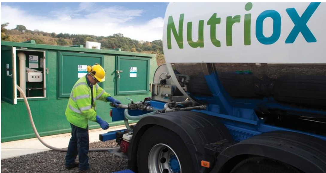
Figura 36 Nitrato de calcio en alcantarillas
