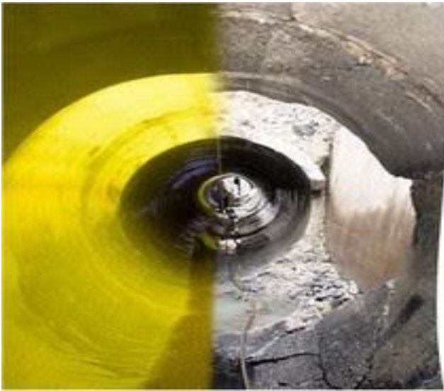
Figura 33 Revestimiento de tubería curado en el lugar CIPP
