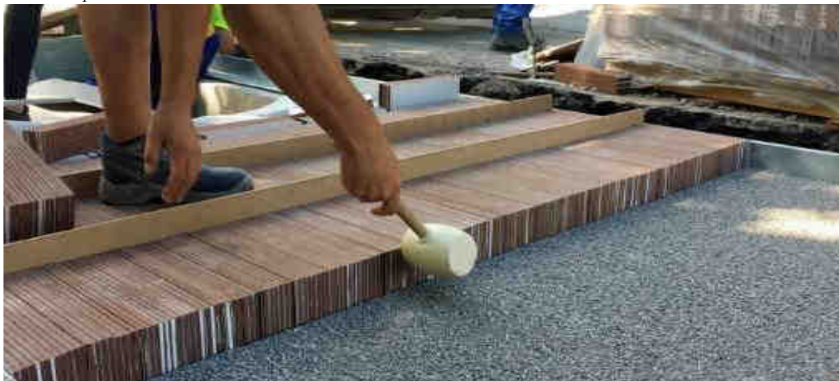
Pavimento permeable con baldosas de cerámica
