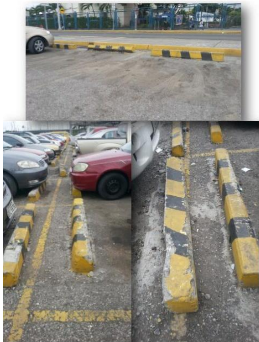
Figura 28. Condiciones actuales de los topes.
