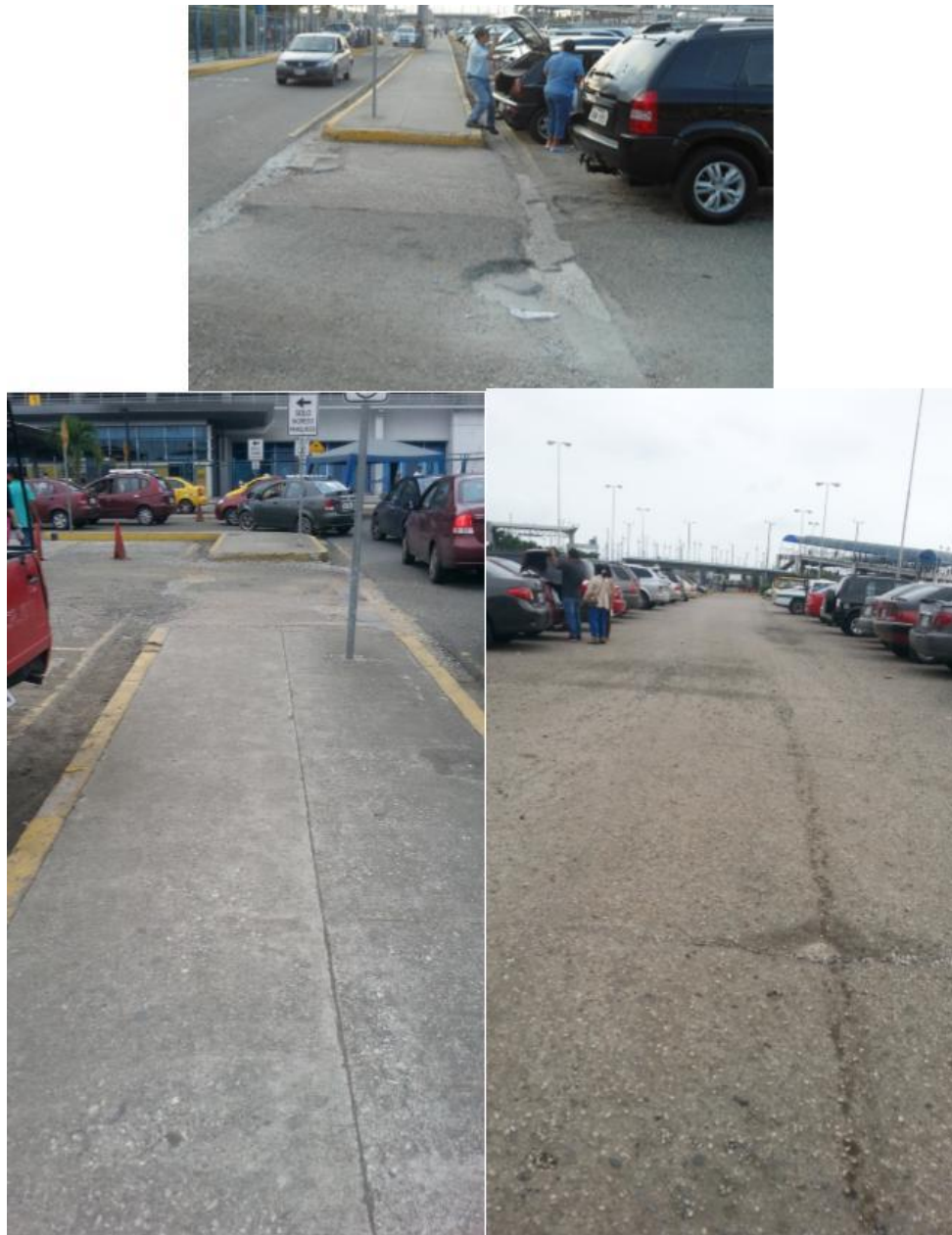
Figura 26. Carpeta asfáltica actual.
