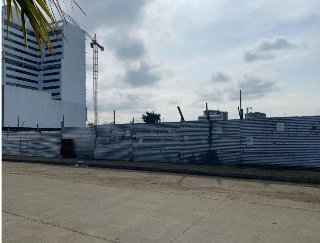
Ilustración 36. Cerramiento perimetral del terreno
