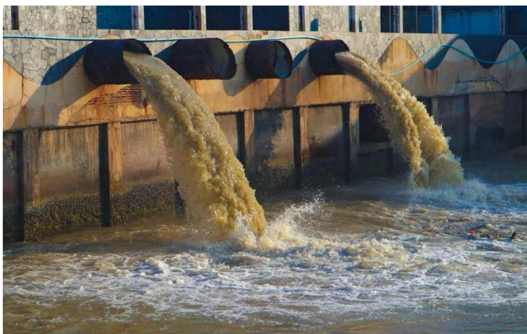
Figura 5 Aguas residuales domésticas
