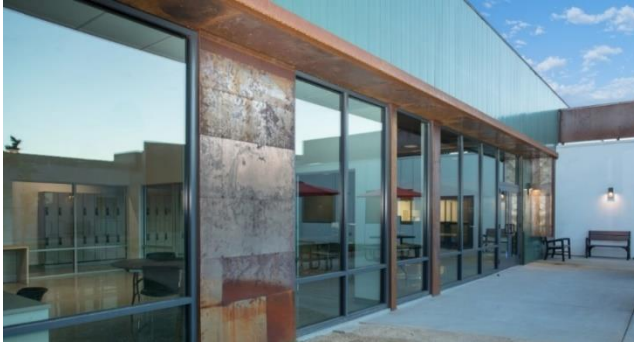
Ilustración 66. Ventanales amplios de la sala de estar
