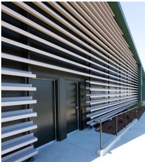
Ilustración 67. Fachada principal de la edificación
