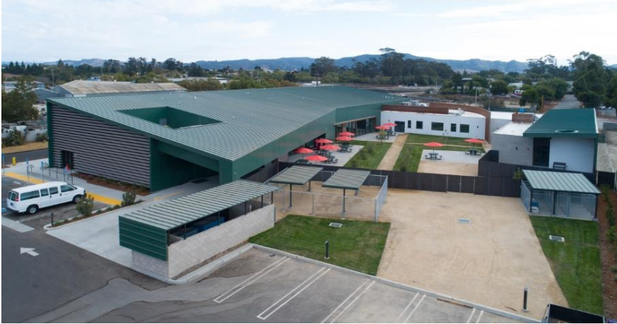
Ilustración 65. Parte trasera del centro de acogida 40 Prado
