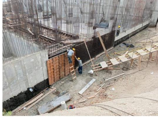
*Hormigón ciclópeo bajo losa de cimentación*
