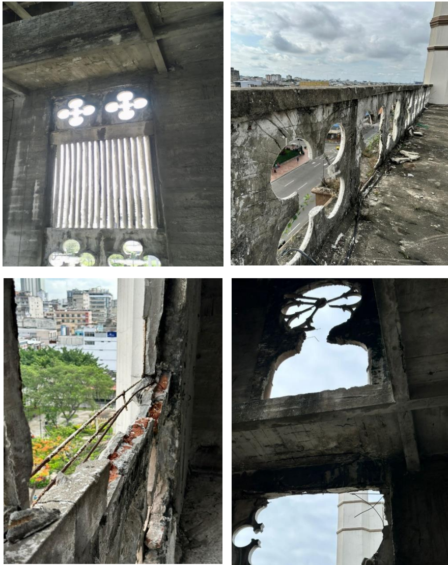
Figura 39 Elementos no estructurales
