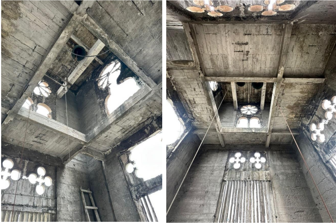
Figura 38 Torre Norte Nivel 3 y Cubierta
