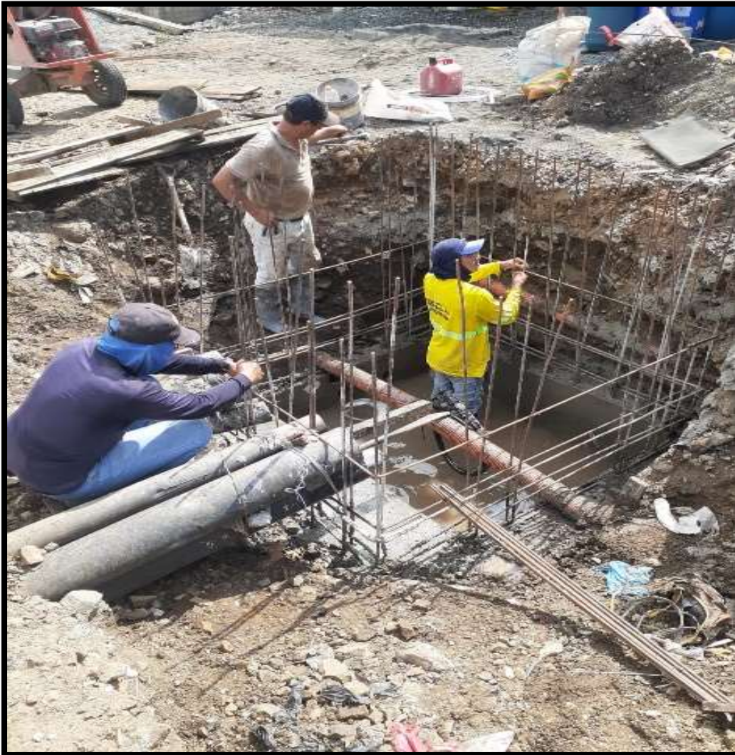
Figura. 16 Armado de estructural.
