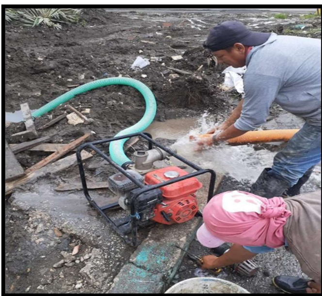
Figura. 4 Extracción de agua por bombeo.
