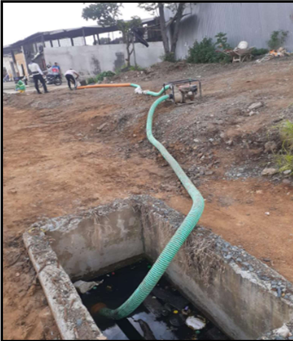
Figura. 5 Extracción de aguas en caja de paso.
