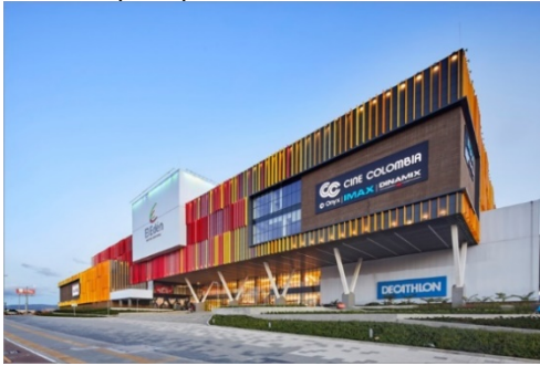
Ilustración 39. Fachada principal del Centro Comercial
