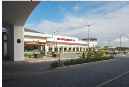
Ilustración 42. Fachada principal de la estructura
