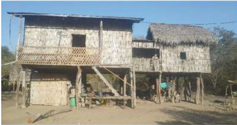
Ilustración 47. Vivienda Tres Espacios, La Chacra, Portoviejo.
