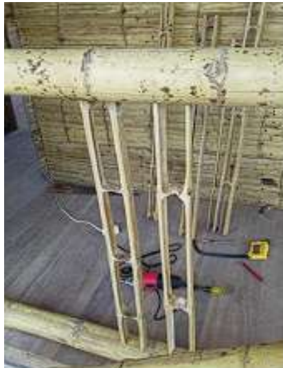
Ilustración 19. Método Constructivo con la Guadua.
