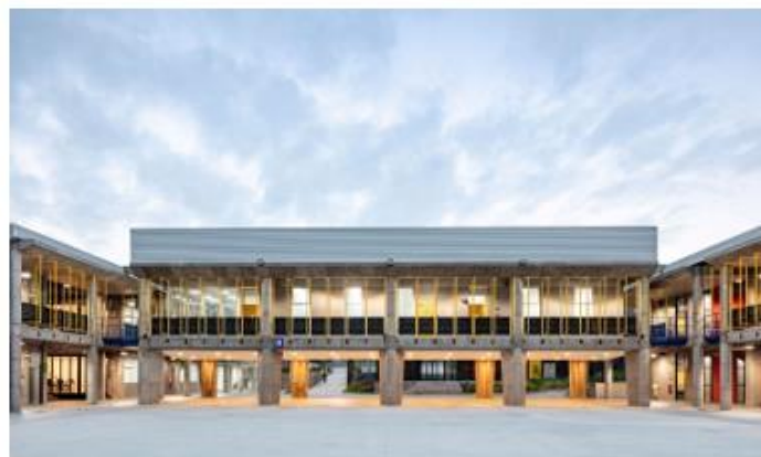
Figura 44 Fachada de instalaciones exteriores
