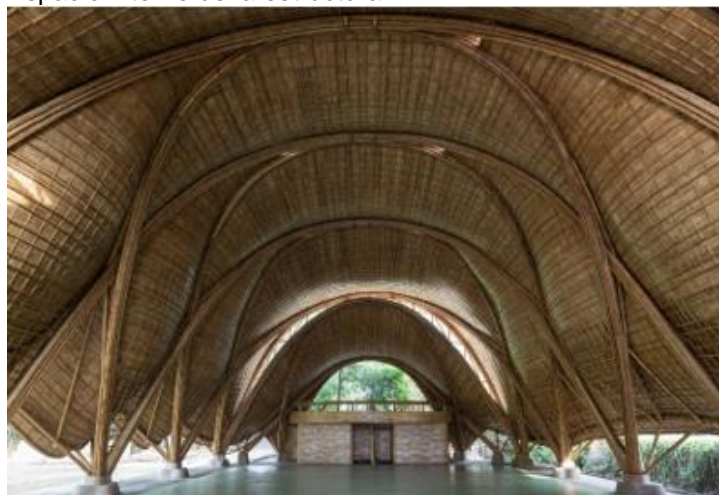
Figura 5 Espacio interno de la estructura
