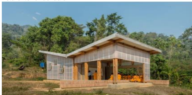
Figura 40 Vista exterior del aula
