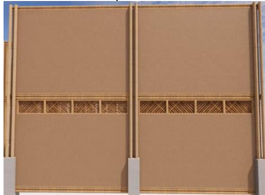
Figura 84 Revestimiento de quincha
