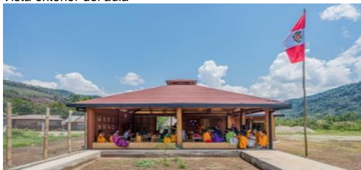
Figura 42 Vista exterior del aula
