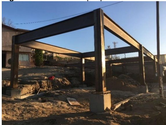
Figura 41: Cimentación por plintos
