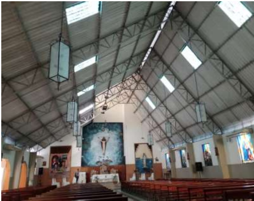
Figura 25 Armado en cercha
