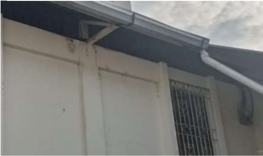
Figura 24 Vigas de hormigón armado
