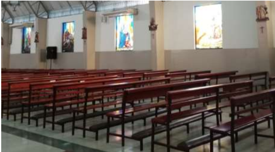
Figura 26 Columnas internas en estructuras metálicas
