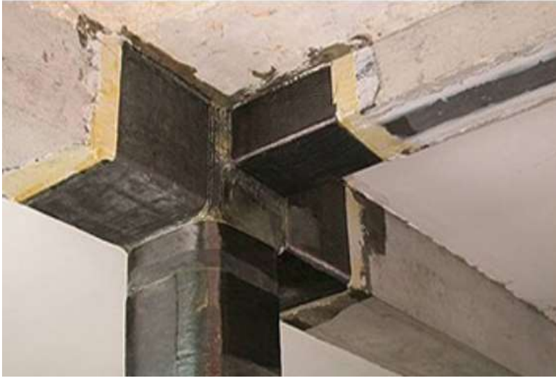
Figura 30 Refuerzo en nudo con fibra de carbono
