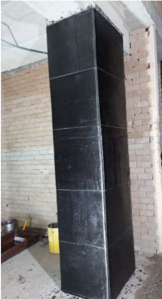
Figura 33 Reforzamiento con fibra de carbono
