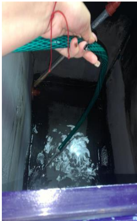
Figura 11 Habilitación del banco hidráulico
