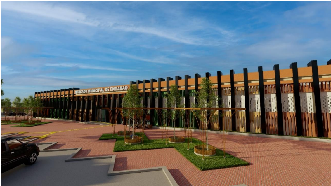
Figura 202. Vista general fachada sur.
