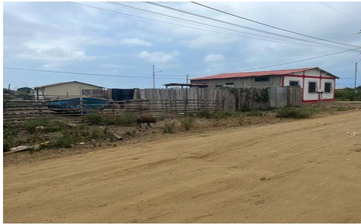
Figura 159. Ausencia de aceras.
