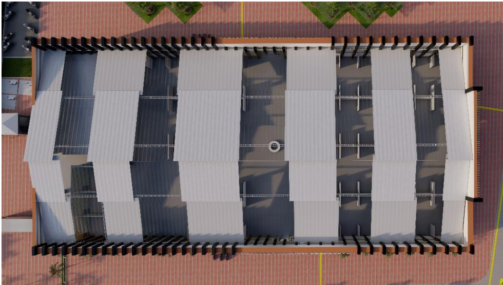
Figura 149. Tragaluz de policarbonato en cubierta vista aérea.
