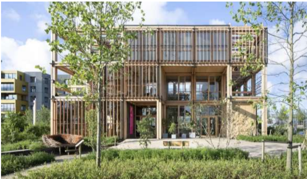
Figura 62. El Pabellón Natural-Fachada
