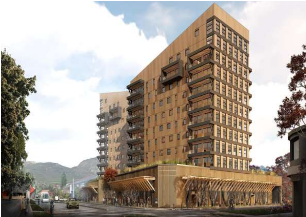
Figura 57. Primer edificio en altura de América Latina-Chile
