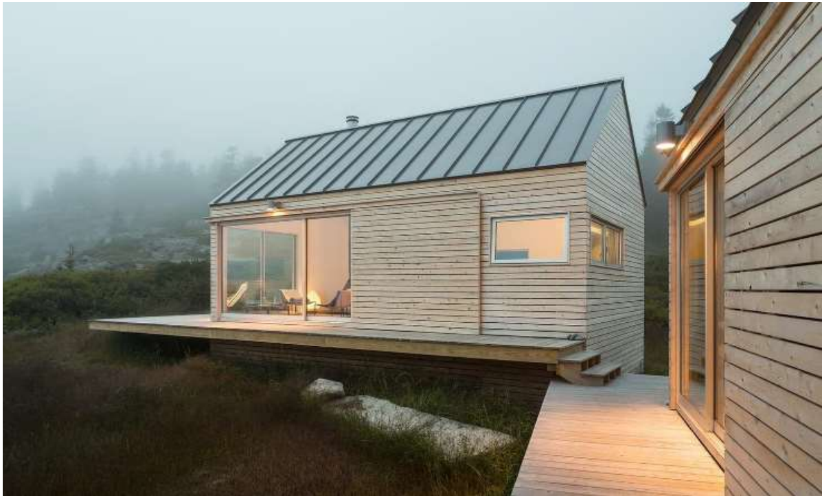
Figura 56. Cabaña del bosque prefabricada con CLT
