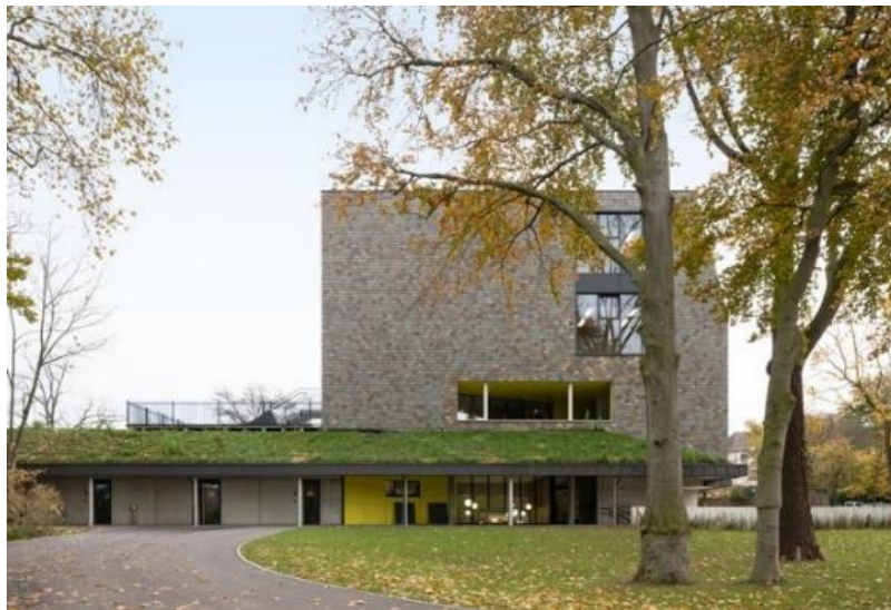
Ilustración 41. Fachada de la escuela Hoek
