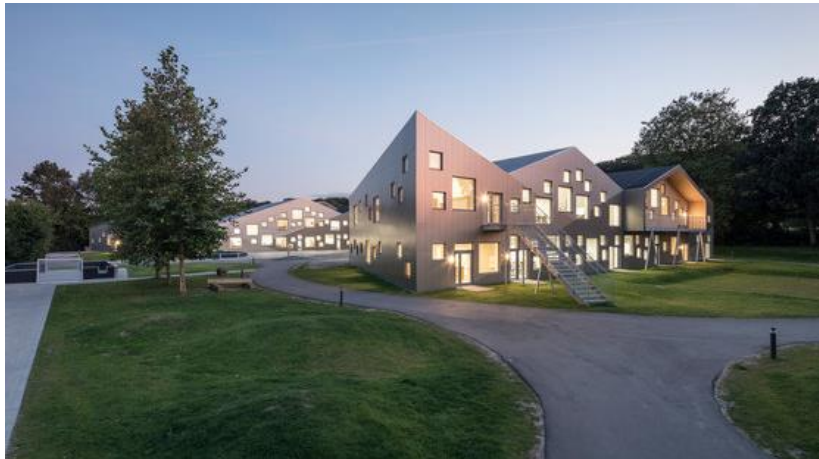
Ilustración 38. Fachada de la escuela Skovbakke
