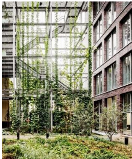
Ilustración 56. Edificio de oficinas con invernadero en la azotea
