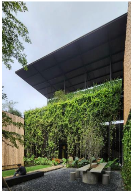
Ilustración 52. Fachada de las oficinas Vibes
