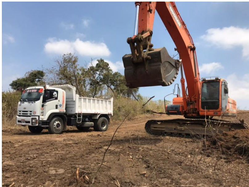
Figura 8. Volqueta y tractor de carga sobre oruga. Fuente: @transportes.mirava
