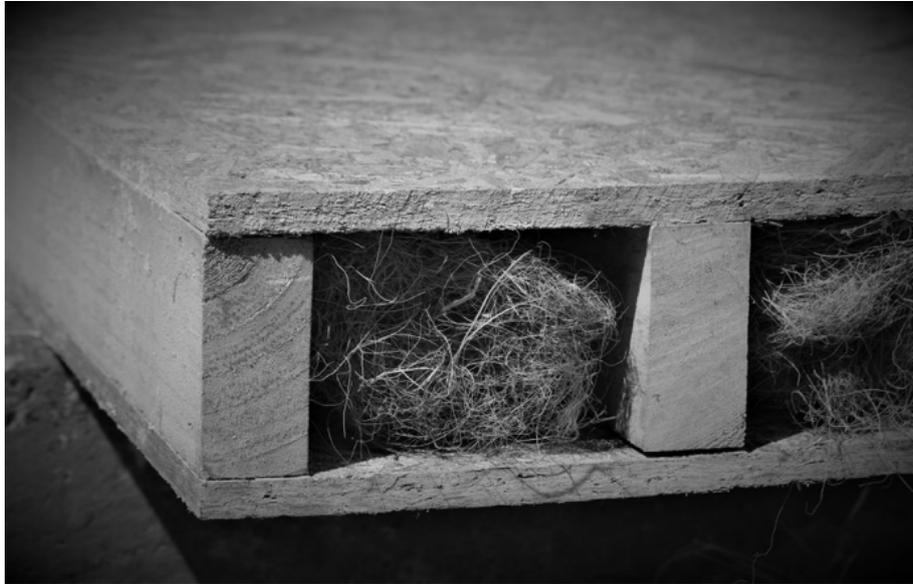
*Figura 2: Fibra de coco en muro de madera.*
