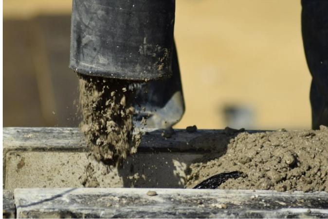
*Figura 39: Construcción de Muro con Hormigón Armado*
