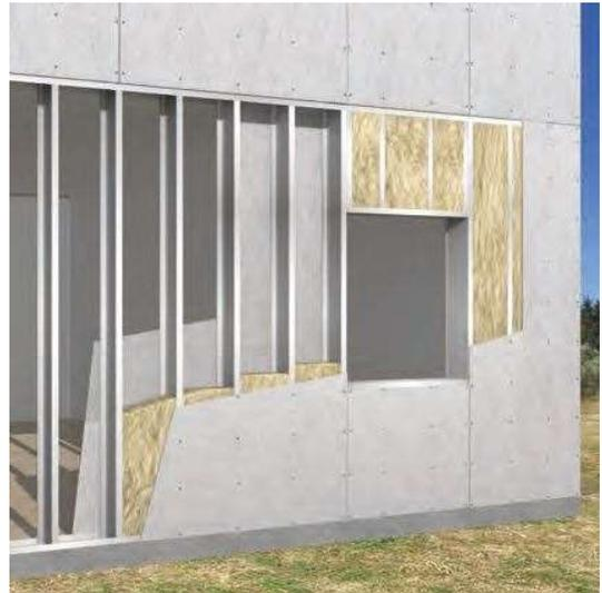
**Figura 46:** Pared de placas de fibrocemento
