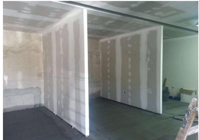
**Figura 48:** Paredes de Gypsum
