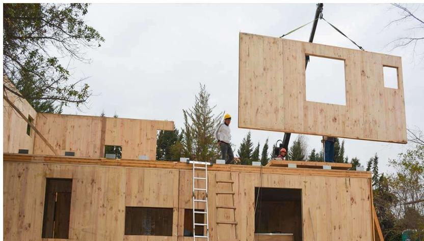
**Figura 44: construcción utilizando CLT.**
