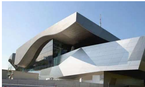
Ilustración 25: Fachada recubierta de acero inoxidable. Fuente: (Group, 2022)
