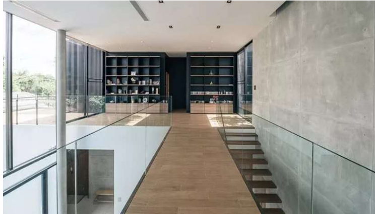
Ilustración 26: Paredes de hormigón visto Fuente: (Becosan, 2021)
