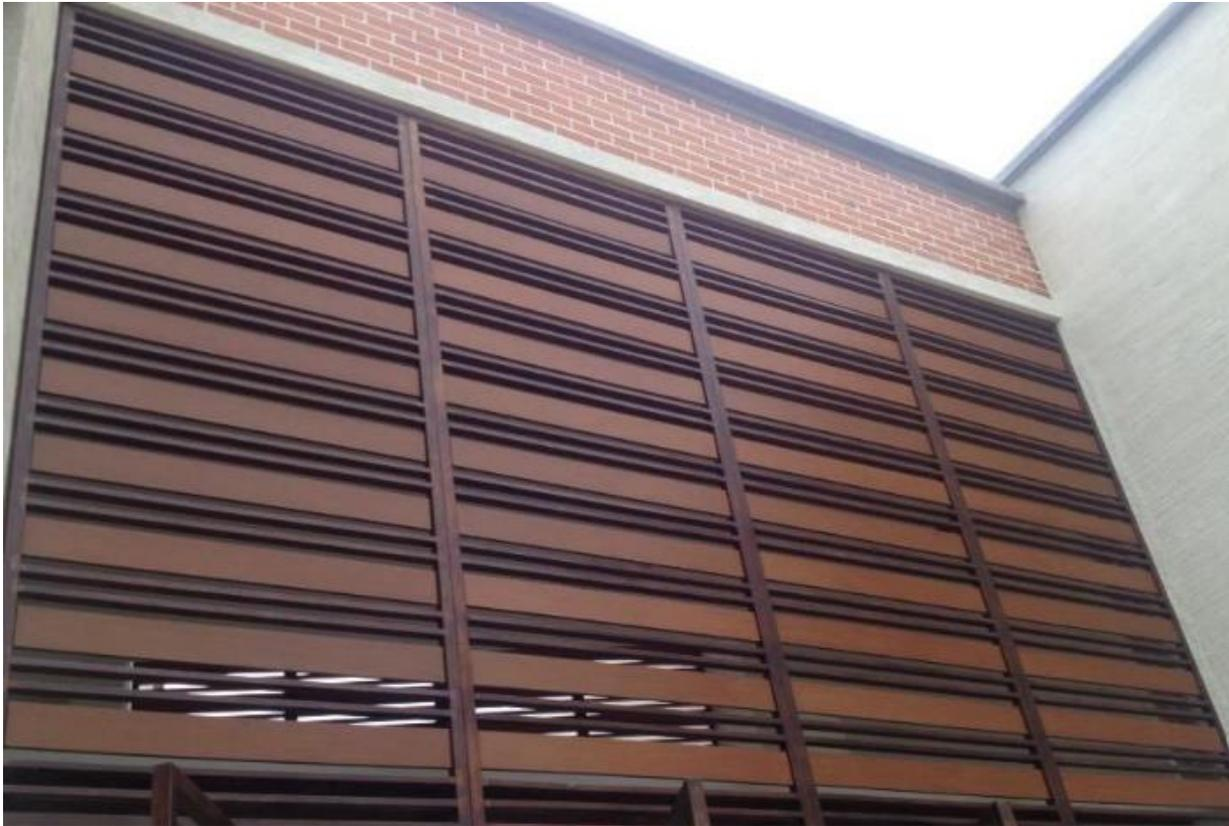
Figura 96: Paneles microperforado de madera plástica en fachadas
