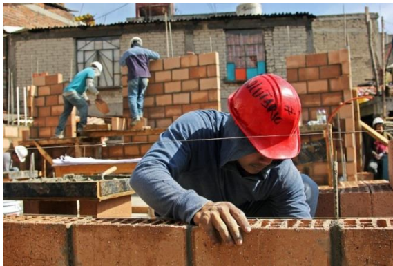
Figura 2. Edificación de una vivienda tradicional.
