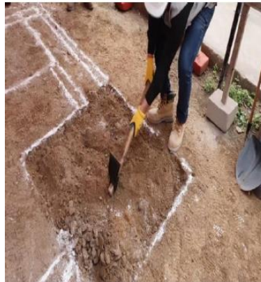
Figura 3. Limpieza y replanteo.
