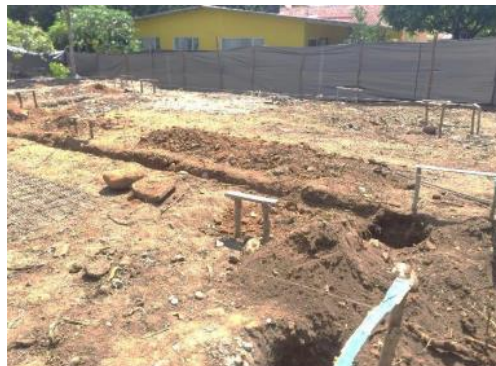
Figura 5. Excavación del material.
