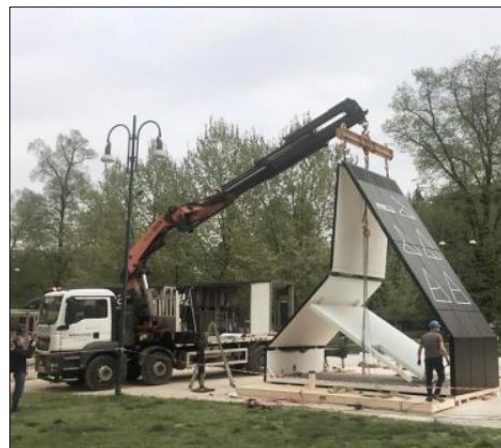
Figura 19. Montaje de una vivienda prefabricada.
