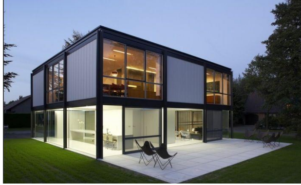
Figura 24. Casa prefabricada de acero.
