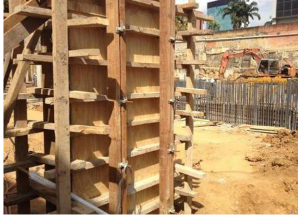
Figura 7. Edificación de columnas.
