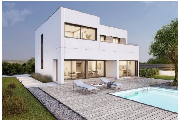
Figura 22. Casa prefabricada de hormigón.
