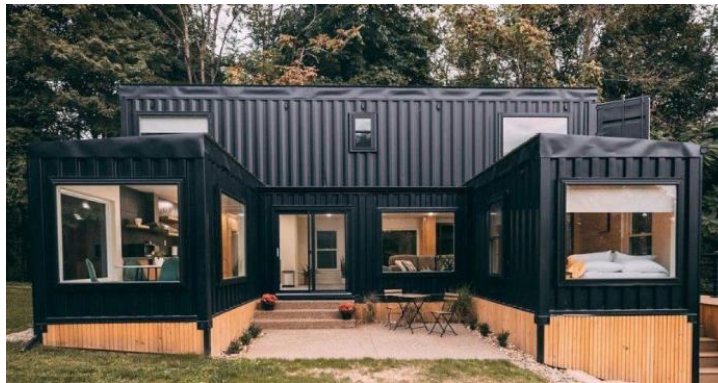
Figura 25. Casa prefabricada de contenedores.
