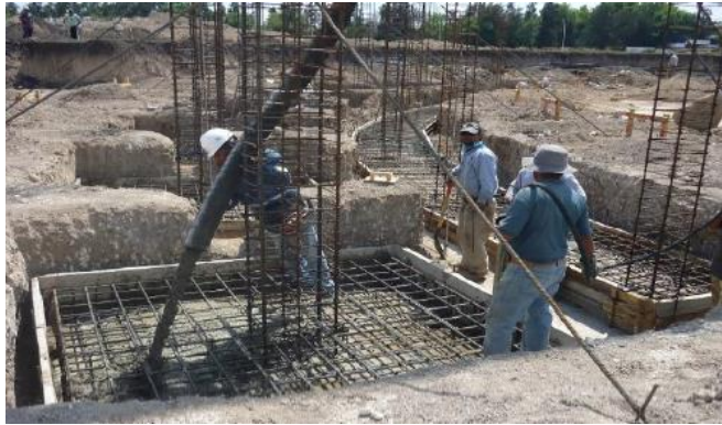
Figura 6. Construcción de zapatas.
