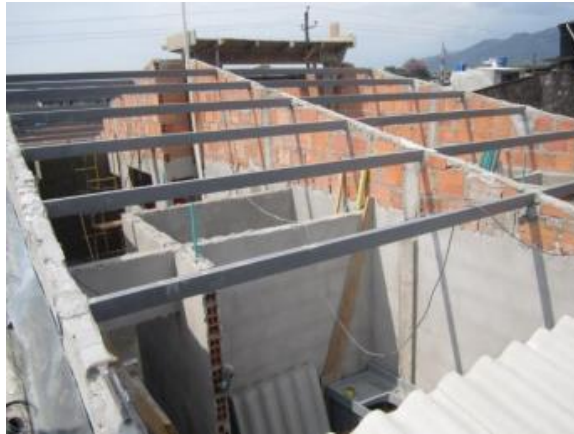
Figura 10. Colocación de cubierta.
