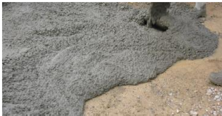
Figura 2: Preparación de hormigón
