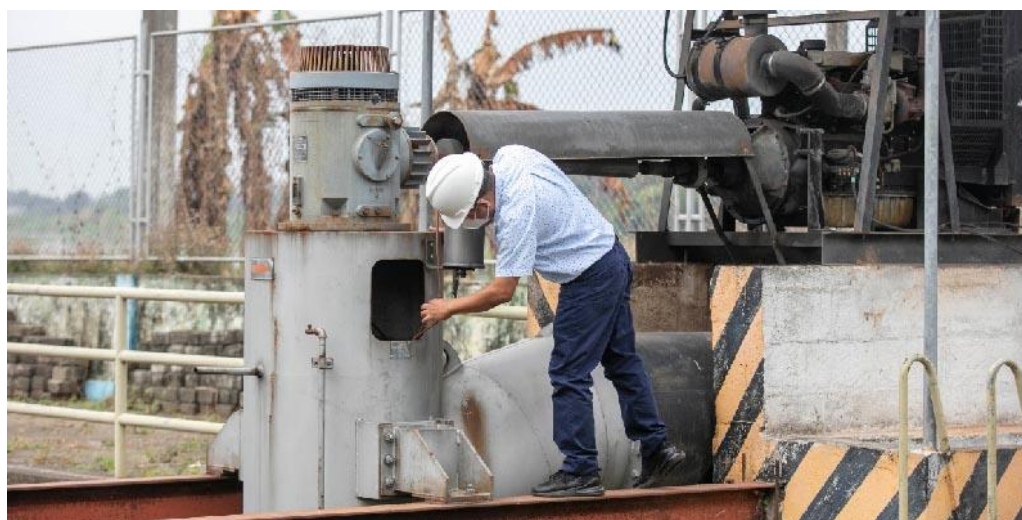
Figura 20. Inspección de bombas para la operatividad.
