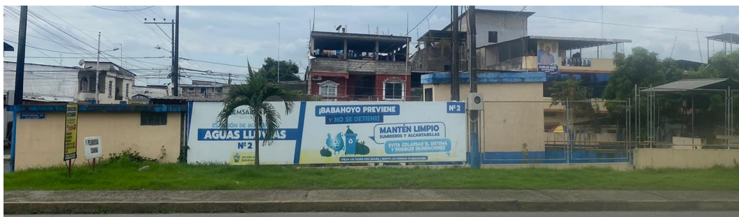
Figura 1. Estación de bombeo N°2 del cantón Babahoyo
