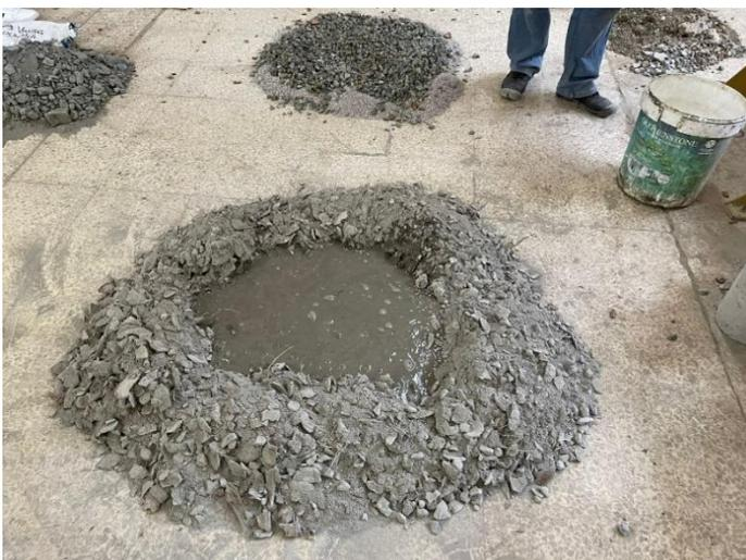
**Figura 19:** Preparación y mezcla de hormigón con adición de concha de coco.
