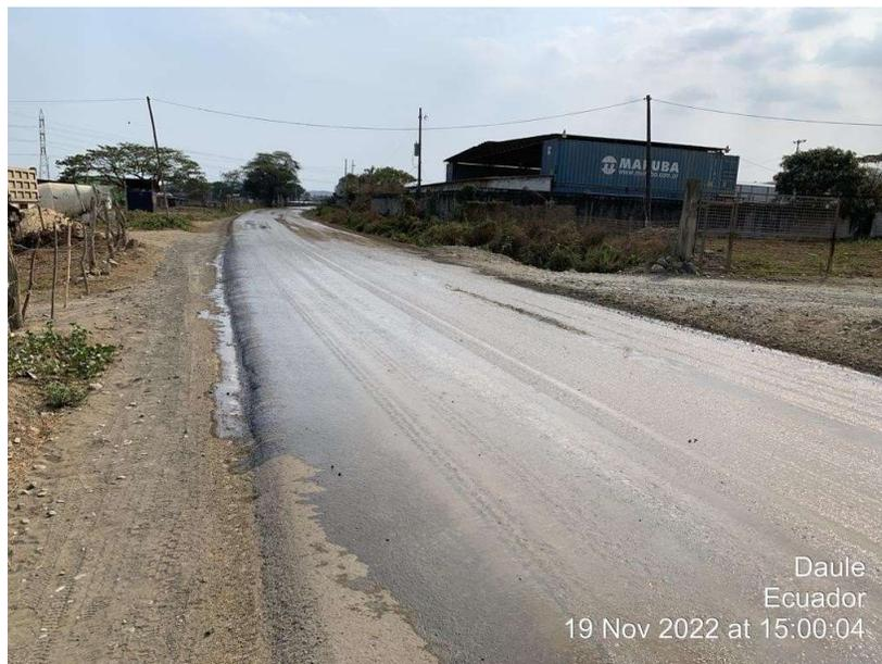
**Figura 10.** Vía con ausencia de bordillos y parterres
