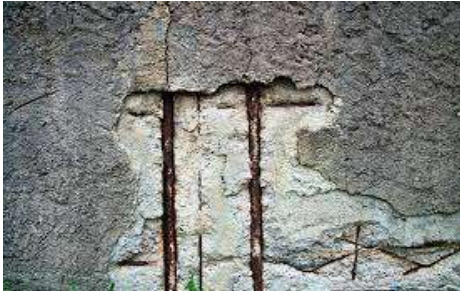
Ilustración 12. Desintegración por fatiga.
