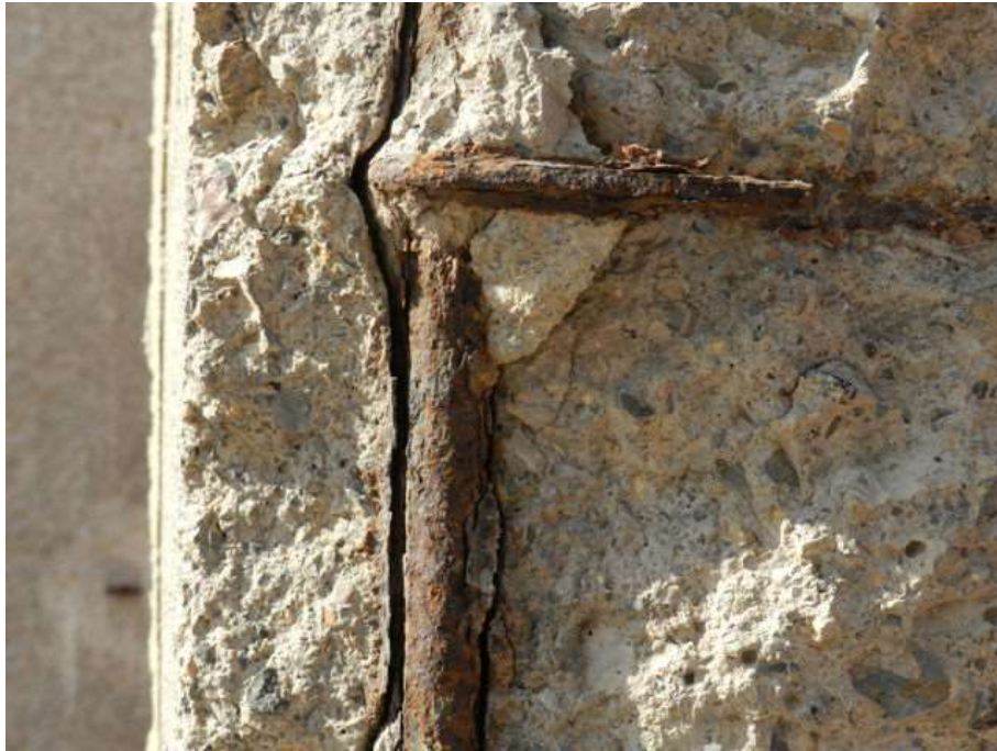
Ilustración 13. Carbonatación
