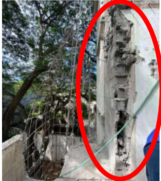
Ilustración 22. Rotura de muro de Municipio de Esmeraldas
