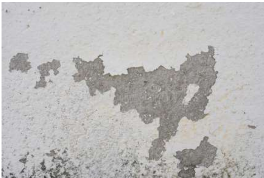
Ilustración 16. Abrasión.
