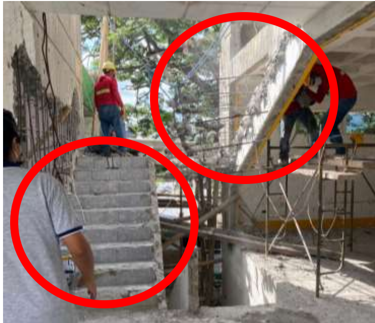
Ilustración 28. Fallo en escalera (Municipio de Esmeraldas)
