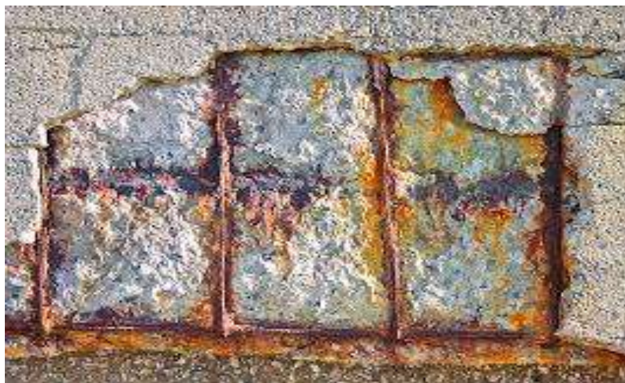
Ilustración 14. Corrosión.
