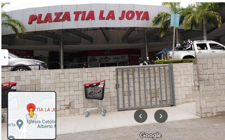
Ilustración 3 Exterior frontal de Plaza Tía La Joya. Fuente: Google Maps
