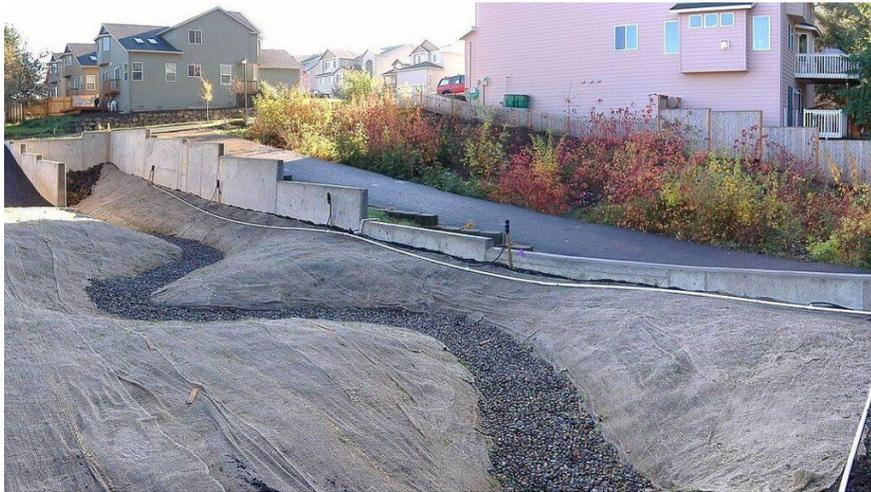
**Figura 7.** Ejemplo de Ralentización por medio de relieves sinuosos
