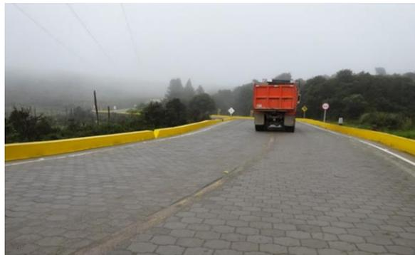
Figura 9 Adoquín de tránsito vehicular pesado
