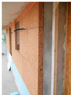
*Ilustración 41. Ejemplo aislamiento térmico con corcho.*
