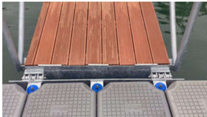
Imagen 66: Sistema articulado de la pasarela de aluminio
