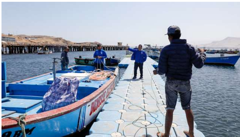
Imagen 9: Muelle flotante ubicado en San Juan de Marcona
